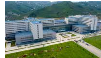
Ordu Şehir Hastanesi Ülke: Türkiye Sektör: İnşaat Jeneratör: 9 x FR 2750 M Toplam Güç: 19,8 MW
