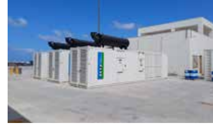
Libya Bingazi Terminal Port Projesi Ülke: Libya Sektör: İnşaat Jeneratör: 5 x AP2500, 4 x AP1650 Toplam Güç: 15,2MW
