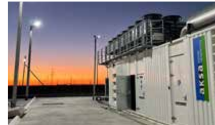
Aktobe Powerplant Projesi Ülke: Kazakistan Sektör: Enerji Jeneratör: 5 x ACG 2000 Toplam Güç: 10 MW
